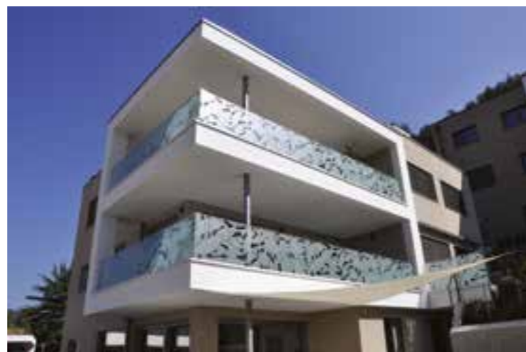
Chriselehof Villen // 2015 2017, Progetto abitativo in Bressanone, Villaggio composto da quattordici case plurifamiliari Elaborazione e colorazione particolare di facciate, garage e delle porte interne al garage Realizzazione di balconate // circa 550 metri lineari, vetro con rivestimento di pellicola
